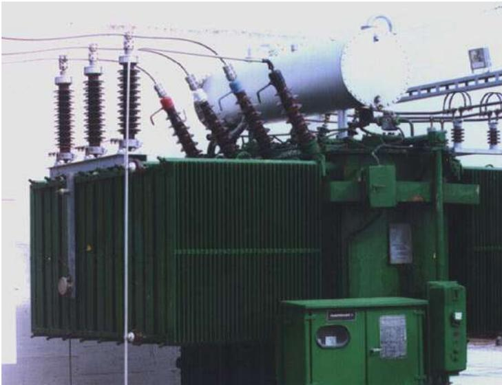
**Fig. 12:** Transformador refrigerado.
