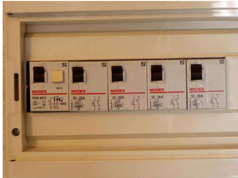
Figura: CGD. A la izquierda está el diferencial con su inconfundible botón de test. A la derecha hay 4 PIA's para los circuitos de: horno, lavadora y termo, tomas de corriente e iluminación.
