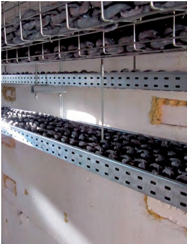
Bandeja portacables con alta carga mecánica ante...
