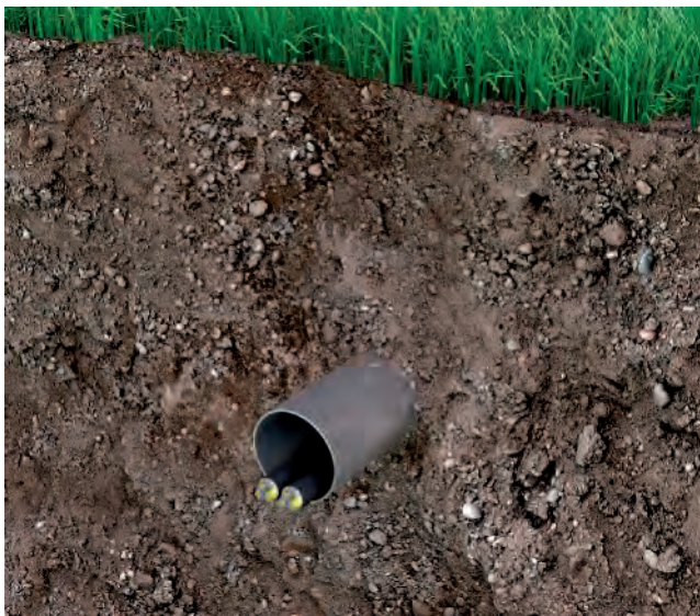
Tendido en tierra
