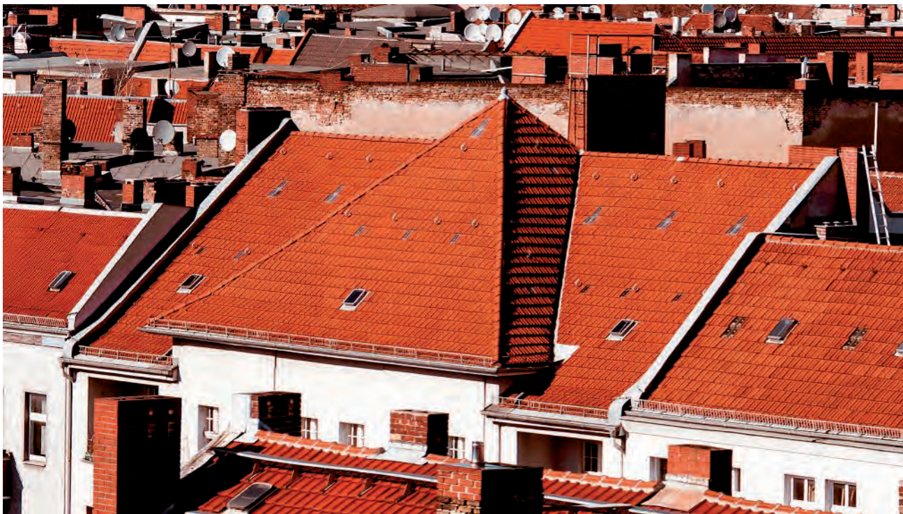
Los muros cortafuegos impiden que el fuego se propague
