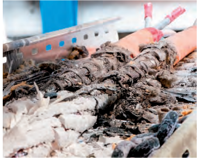
...y tras el ensayo contra incendio
