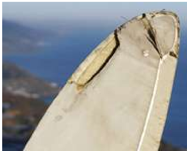
Detalle obtenido por inspección preventiva realizada con dron
