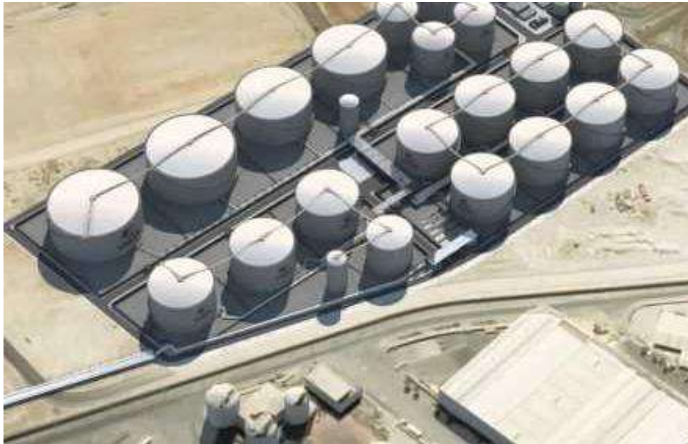
Ilustración 7 Ejemplo de una instalación de tanques de almacenamiento
