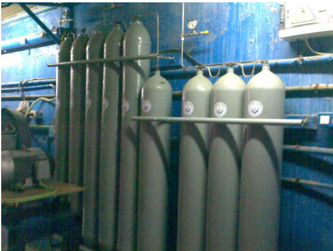
- Fig. 2.5.1.3 Rampa de almacenamiento de aire utilizada para la recarga de equipos de respiración.
